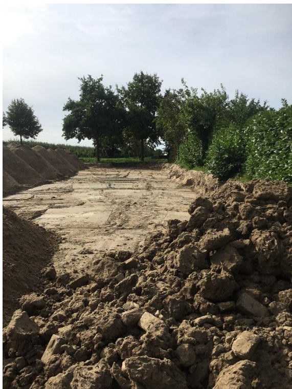
Gecontroleerd ontgraven en zeven zuiden
