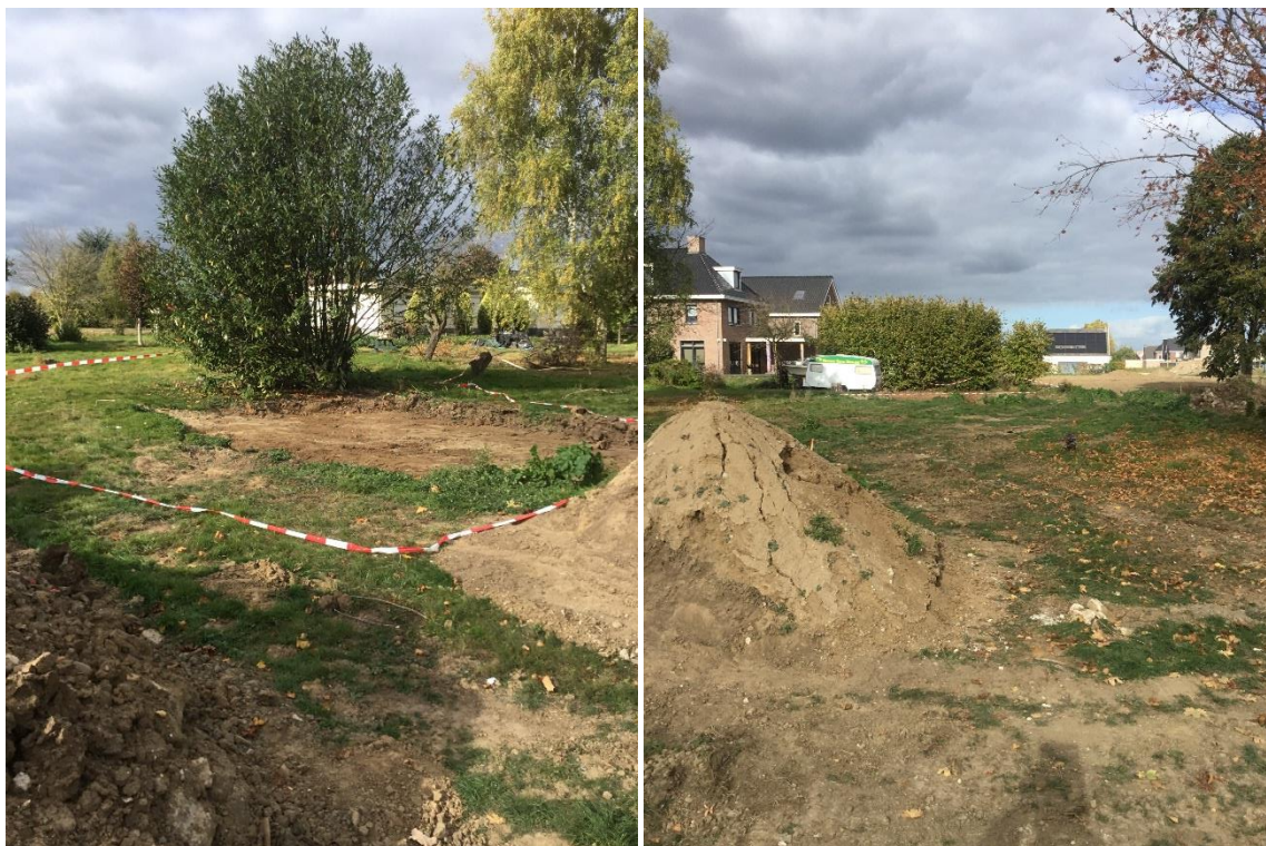
Resultaat saneringswerkzaamheden milieuspot 1
