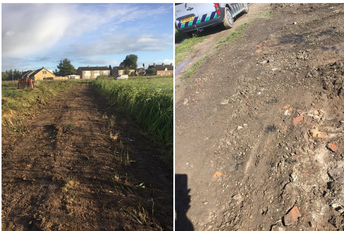
Opschonen met graafmachine (L) en strookje puinpad niet te interpreteren (R)
