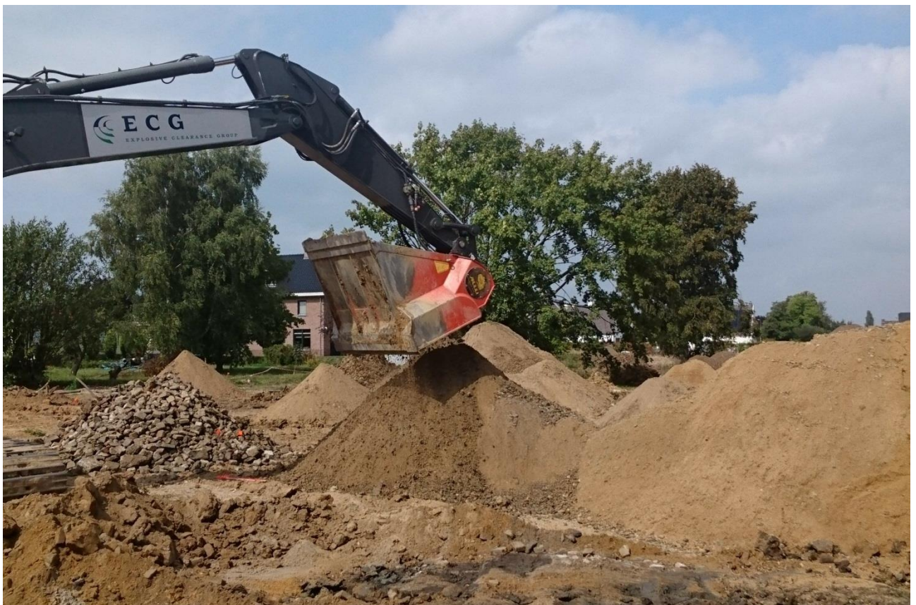
Figuur 3: Gecontroleerd ontgraven.
