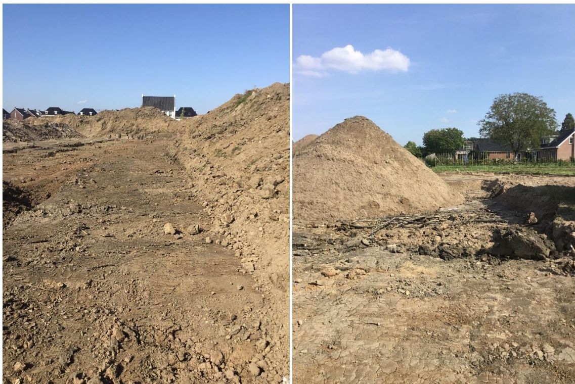
Gecontroleerd ontgraven en zeven noorden en midden
