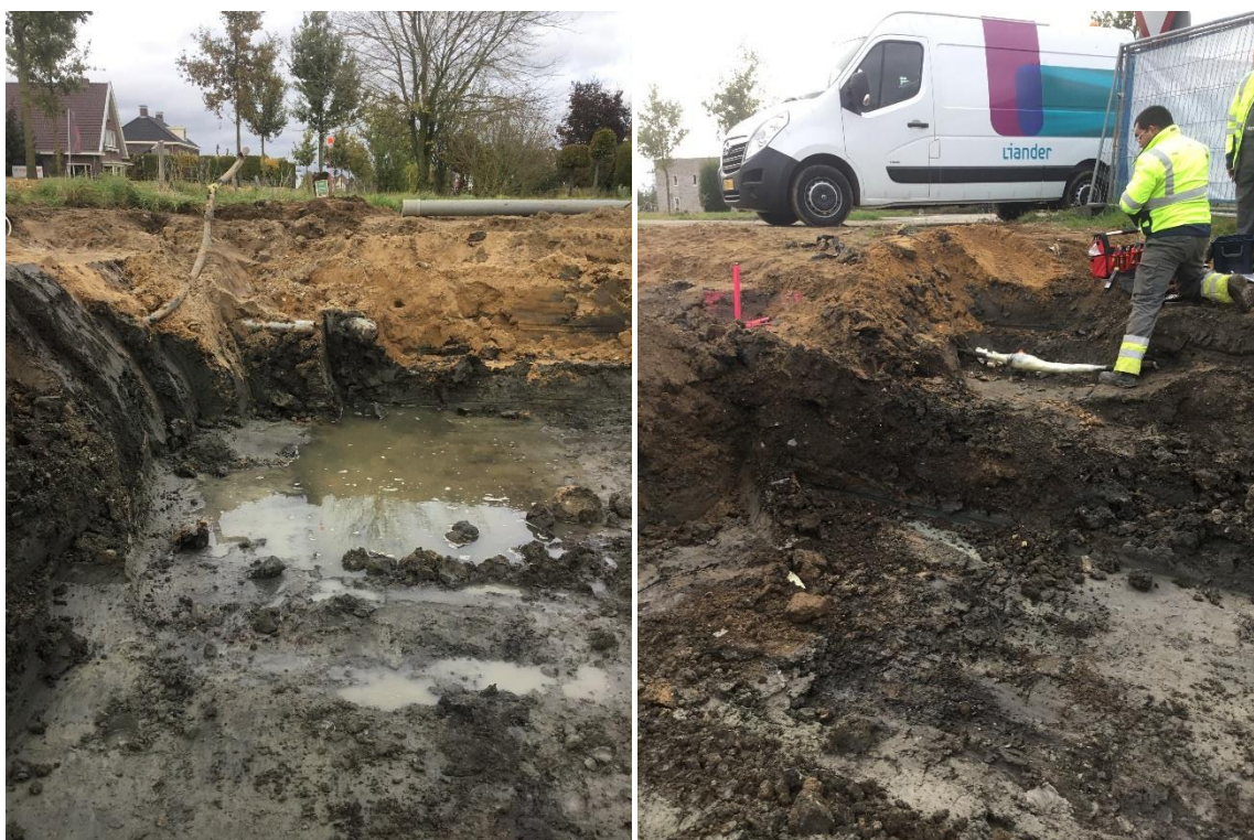
Resultaat saneringswerkzaamheden milieuspot 2
