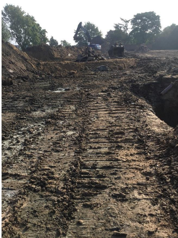
Gecontroleerd ontgraven en zeven midden
