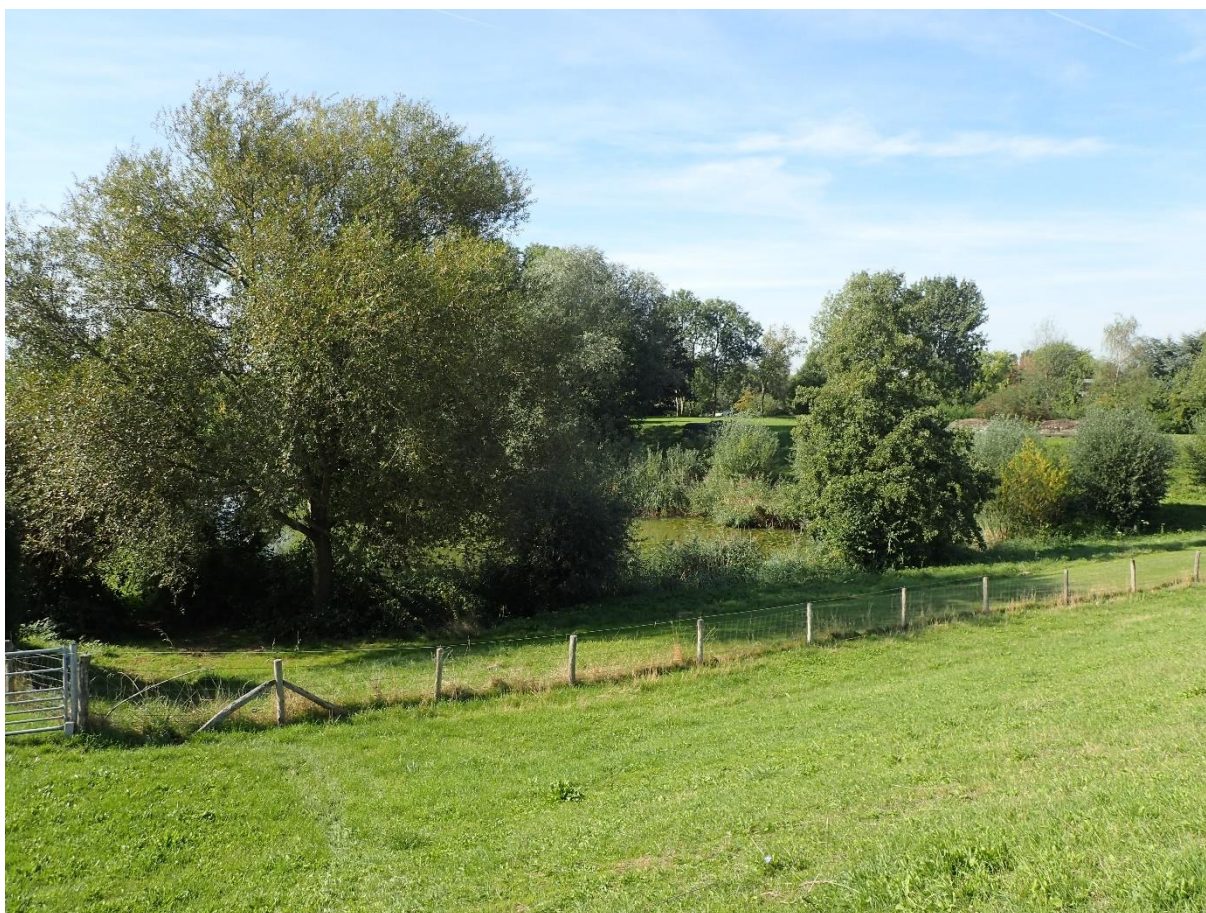
Figuur 33. De met opslag omgeven gracht rond het hoornwerk aan de binnendijkse zijde (foto: RAAP, 22 september 2022).
