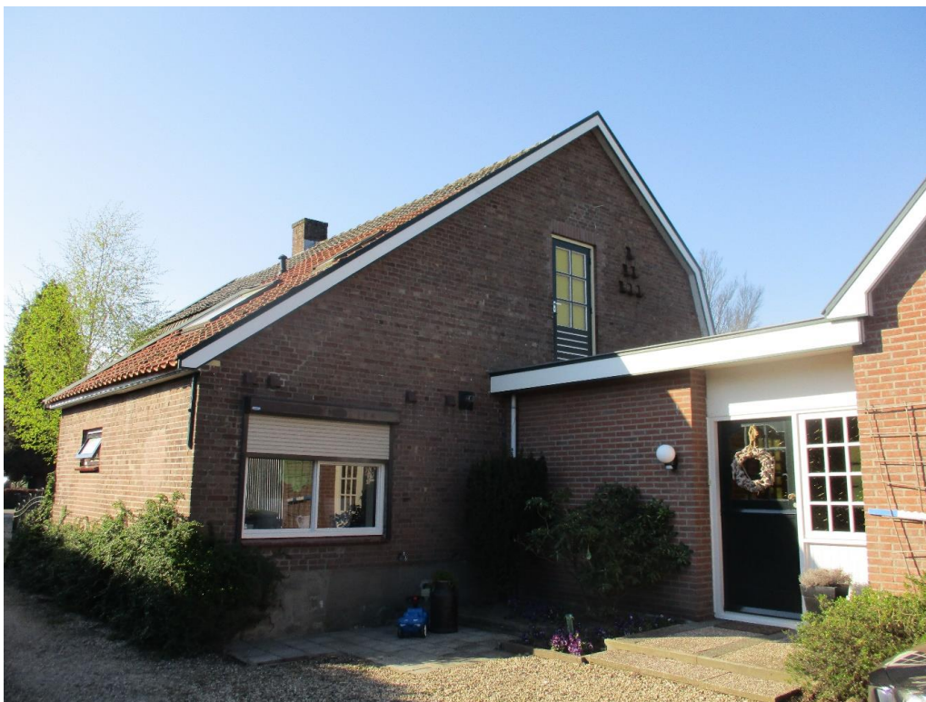
Figuur 1 De woning bestaat uit een gemetselde muur met spouw en mansarde dak met dakpannen. Vanuit deze hoek is de aanbouw te zien, waardoor aan deze zijde een zadeldak is ontstaan met een lage dakrand.
