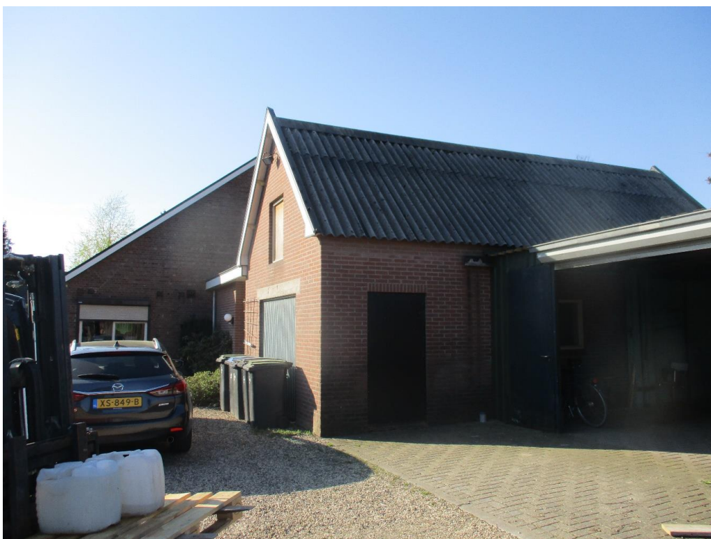
Figuur 2 De garage is opgetrokken uit gemetselde muren met spouw en zadeldak met golfplaten.
