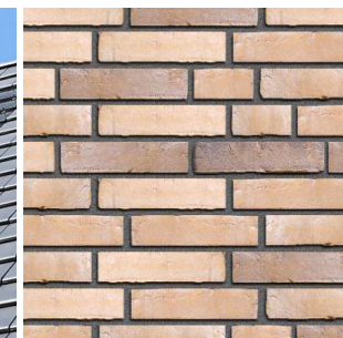
geel/bruin metselwerk woningen aan het middengebied
