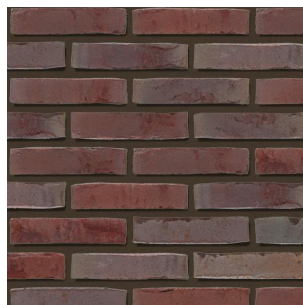
bruin/rood metselwerk woning aan het lint
