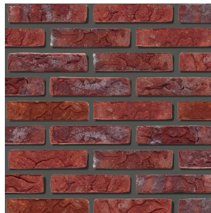
bruin/rood metselwerk woning aan het lint
