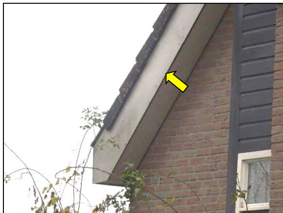
Figuur 16. Ruimte langs de dakrand welke toegang verleend tot ruimte onder de dakpannen.
