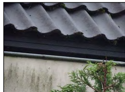
Figuur 15. Dakgoot van het woonhuis welke toegang biedt voor de huismus onder het dak.
