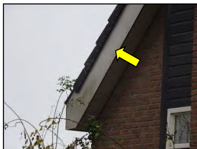
Figuur 14. Ruimte langs de dakrand, welke toegang geeft tot ruimte onder de dakpannen.
