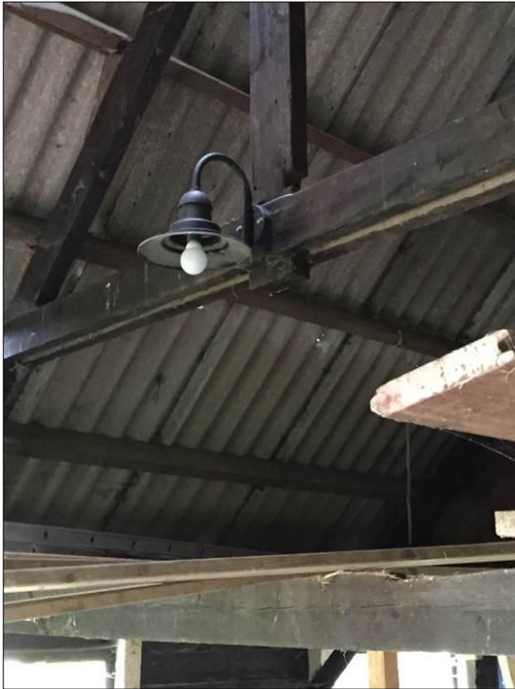
Figuur 13. Binnenzijde houten schuur.
