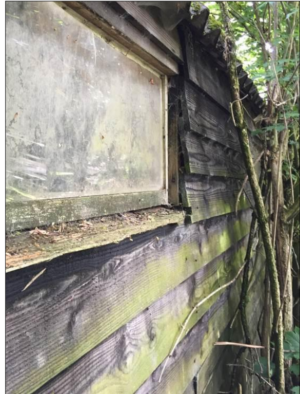
Figuur 14. Potdekselbetimmering aan buitenzijde.
