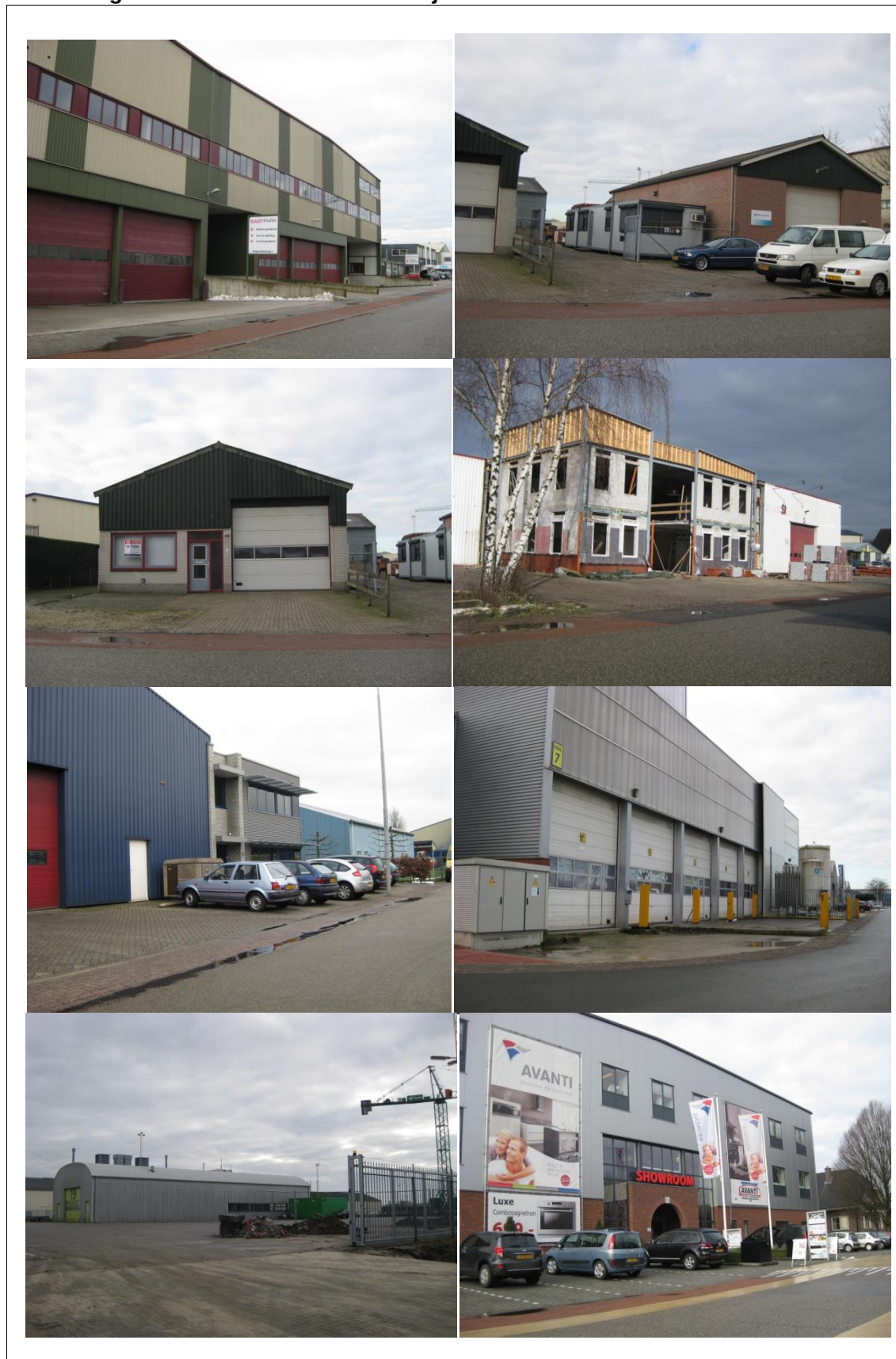
Afbeelding 2.2. Bestaande situatie bedrijventerrein het Panhuis
