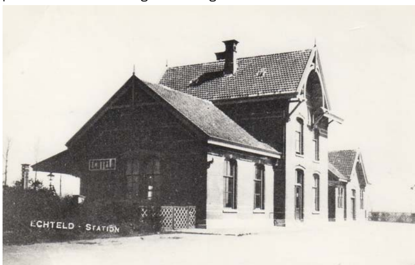
Stationsgebouw straatzijde (bron: stationsweb.nl)
