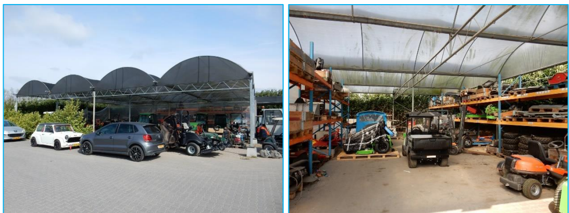
Foto's: Indrukken plangebied. De af te breken overkapping. Buiten- en binnenzijde.
