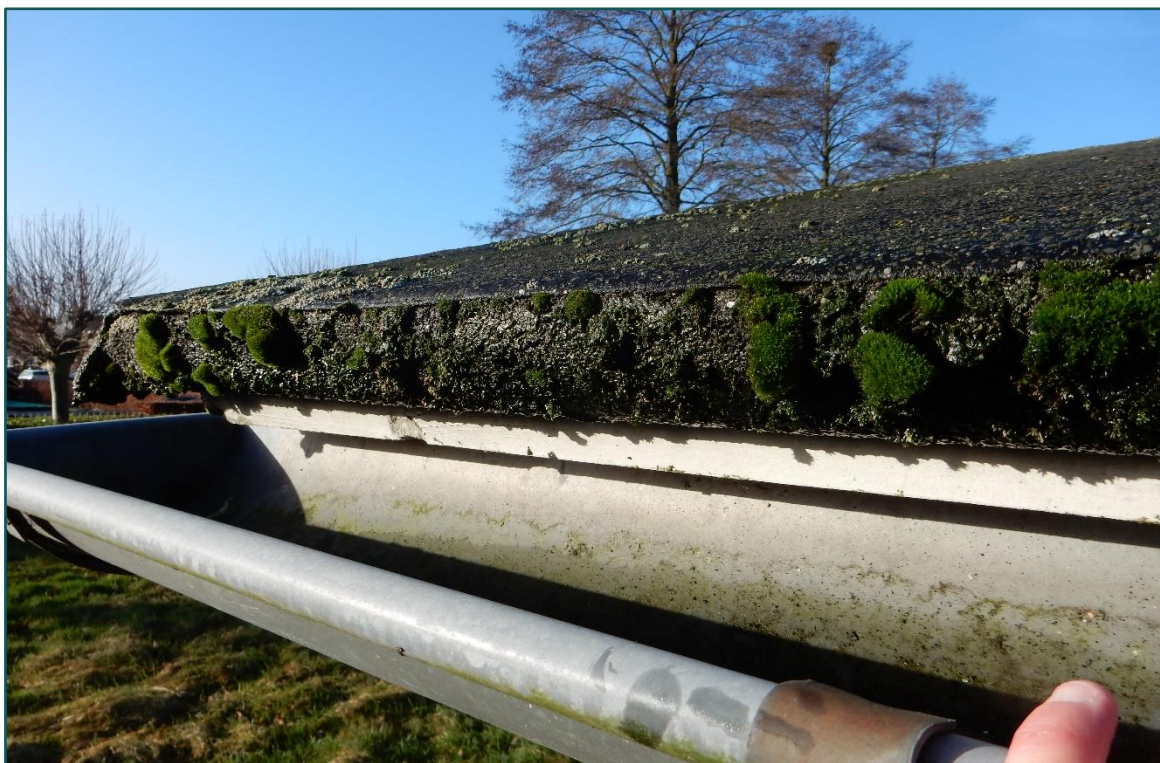
Figuur 3 De dakrand is afgewerkt met bitumen dakbedekking zodat er geen ruimte aanwezig is voor huismussen.
