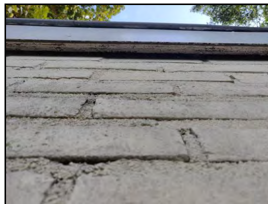
Afbeelding 4: Ruimte achter daklijst
