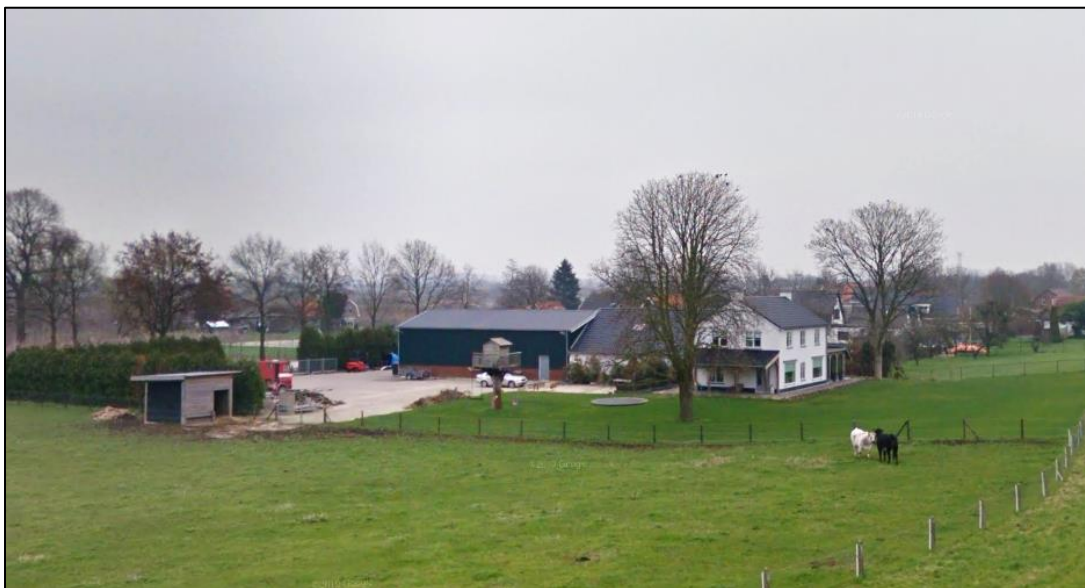
Afbeelding 2.3: Huidige situatie plangebied, vanaf de Waalbanddijk
