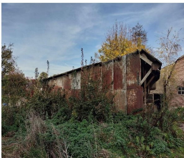
Foto 11: gevels loods bekleed met blik wandplaat
