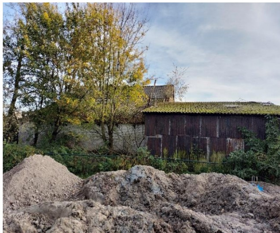
Foto 6: achterzijde loods (1) en zijkant gebouw (2)
