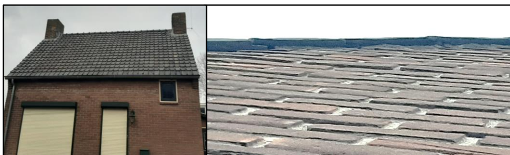
Figuur 4 De dakpannen en kantpannen sluiten nauw aan, waardoor vleermuizen geen toegang kunnen krijgen tot een open dakruimte.
