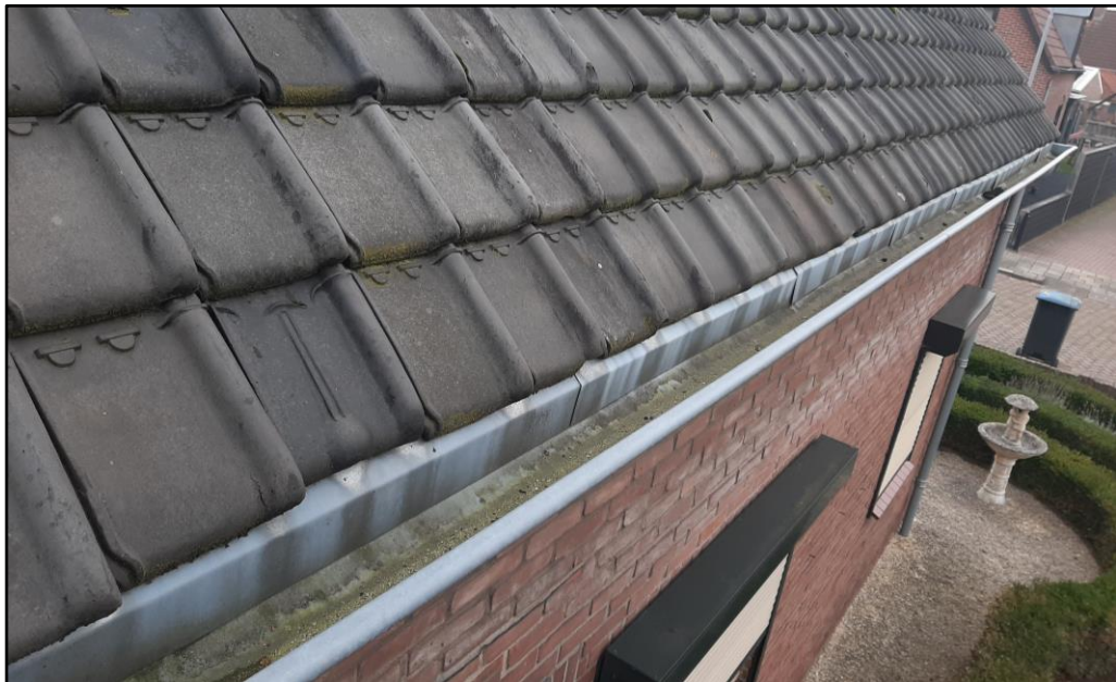
Figuur 5 De onderste rijen dakpannen van het dak van de woning zijn door het type dakpan ontoegankelijk voor huismussen.
