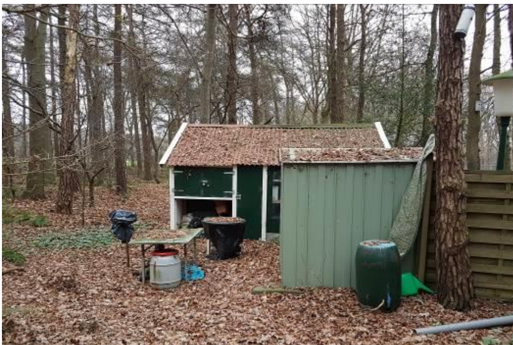
Figuur 4.1-2: Te slopen schuren in het plangebied.
