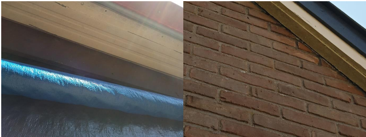
De windveren en betimmering van het dak overstek sluiten naadloos aan op de buitengevels.
