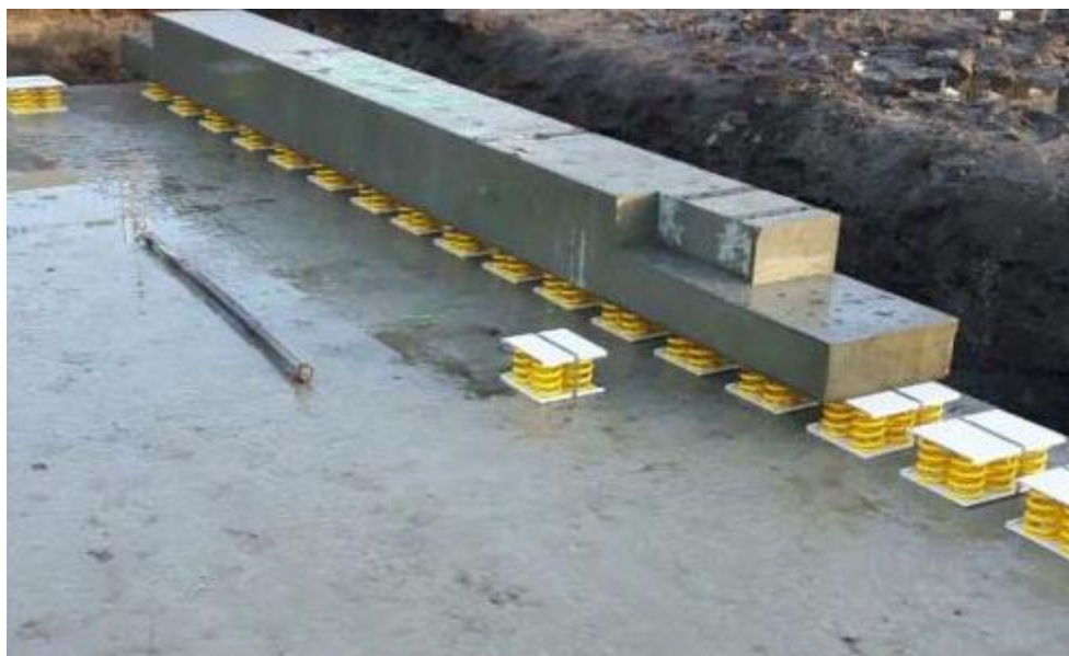
Figuur 28 Dubbele fundering met stalen veerdozen (project in Prinsenbeek)
