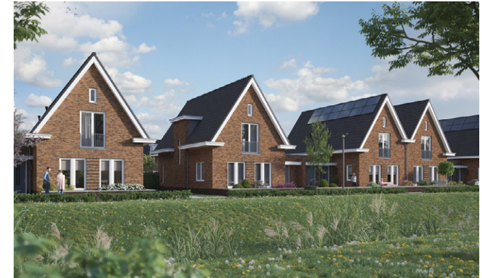
Afbeelding 10: samenhang in bouwvormen met eenduidige materialisatie
