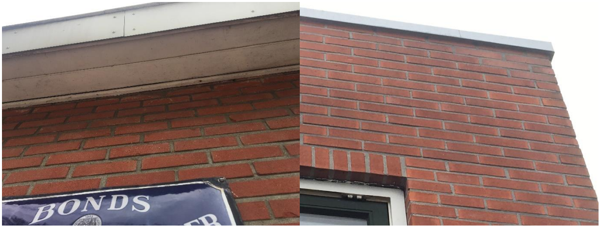
Foto links; de betimmering van het dak overstek sluit naadloos aan op de buitengevels. Foto rechts; de metalen daklijsten sluiten naadloos aan op de buitengevels. .
