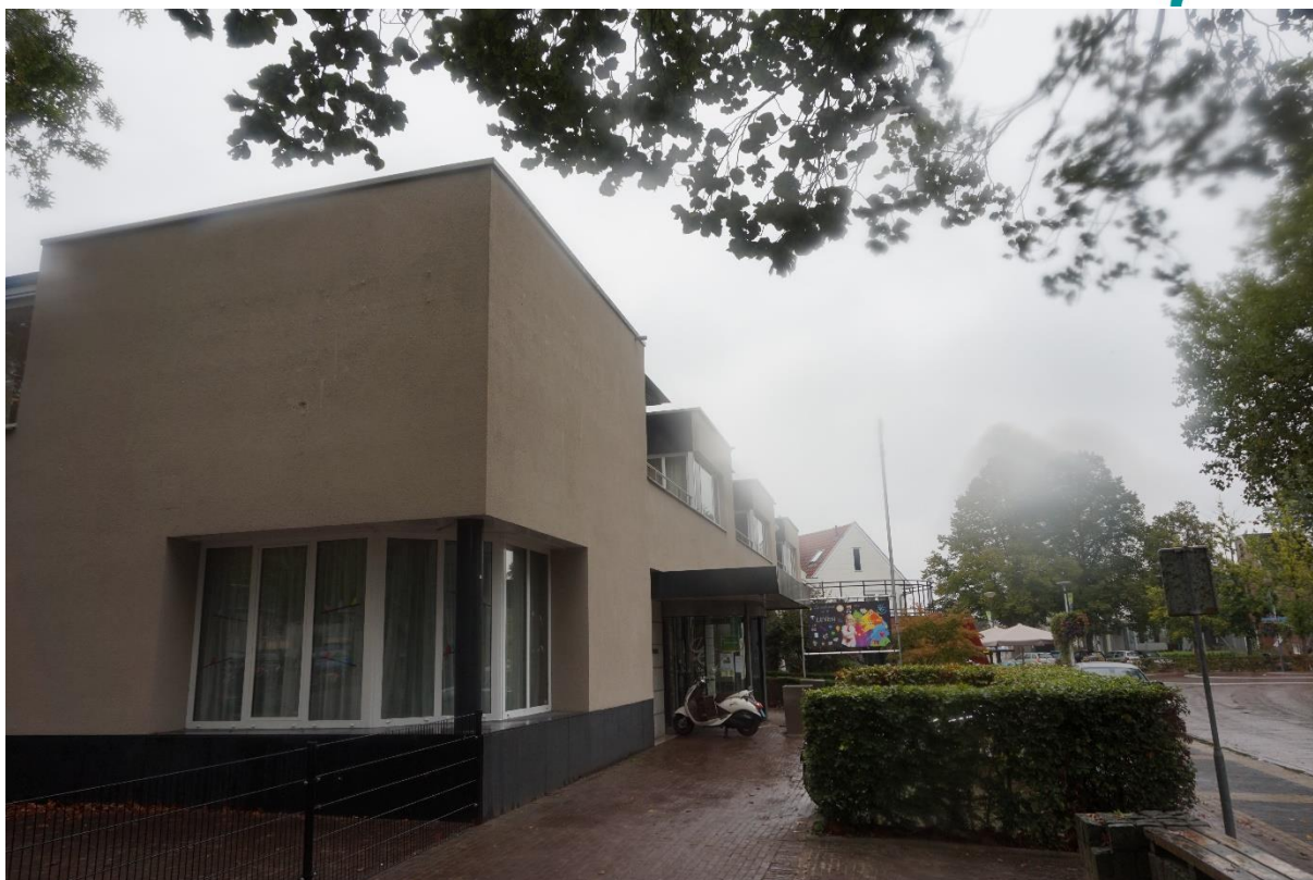
Figuur 2.4. Oostzijde van de onderzoekslocatie.
