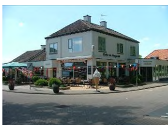
Impressie zalencomplex met café – restaurant en ijssalon kruising Eikenlaan – Onze Lieve Vrouwestraat
