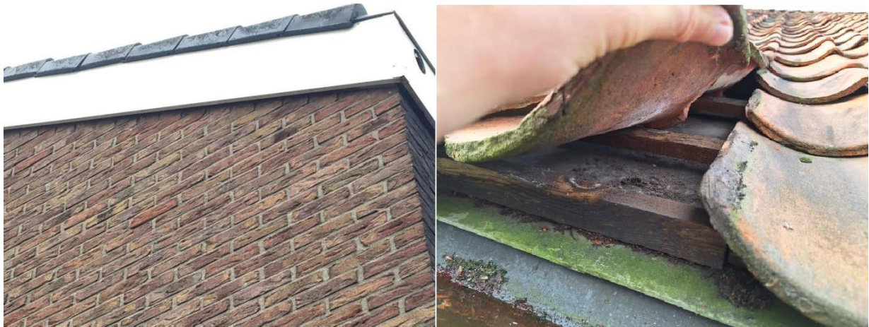
Foto links; De gevelpannen sluiten nauw op elkaar aan. Foto rechts; onder de dakpannen van de boerderij zijn geen oude nesten huismussen vastgesteld.
