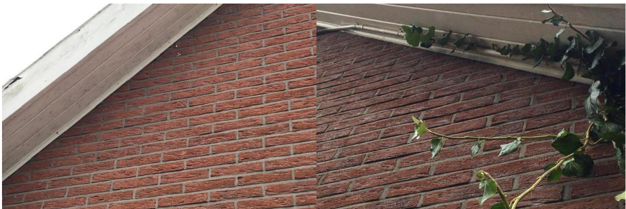
De betimmering van het dakoverstek sluit naadloos aan op de bakstenen buitengevels.
