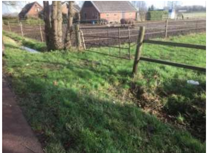
Foto 14 D2 (dam 1 deellocatie 3)
