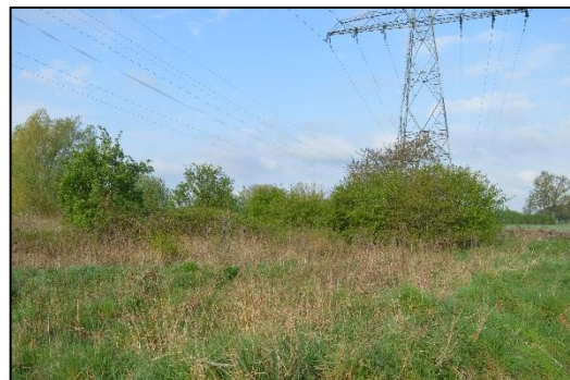
Figuur 4.13. Hoogspanningsmast die omgevormd wordt tot opstijgportaal.
