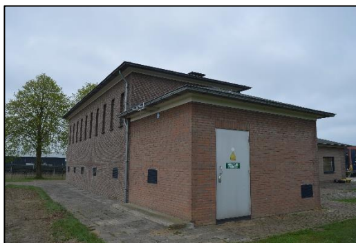
Figuur 4.4. Hoogspanningsstation Goor op station Brownfield.
