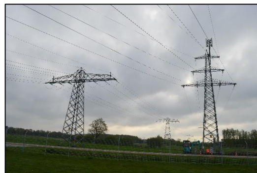
Figuur 4.5. Twee te amoveren hoogspanningsmasten.
