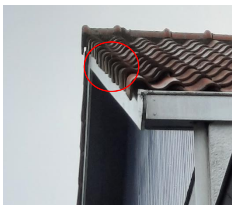
Figuur 5.1: kantpannen, potentiële invliegopening
