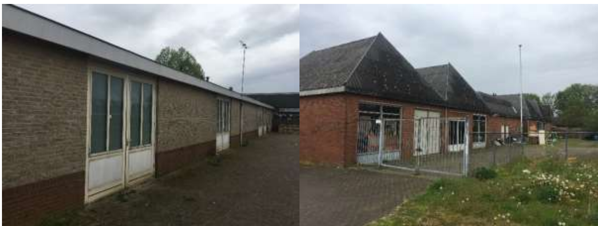
Impressie van de te slopen bebouwing.
