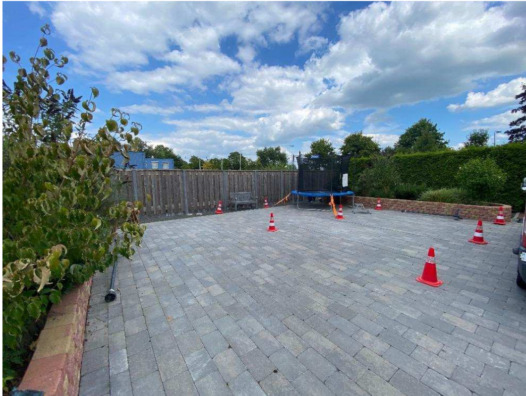
Foto 3. Gruttostraat 47/49 te Goor
