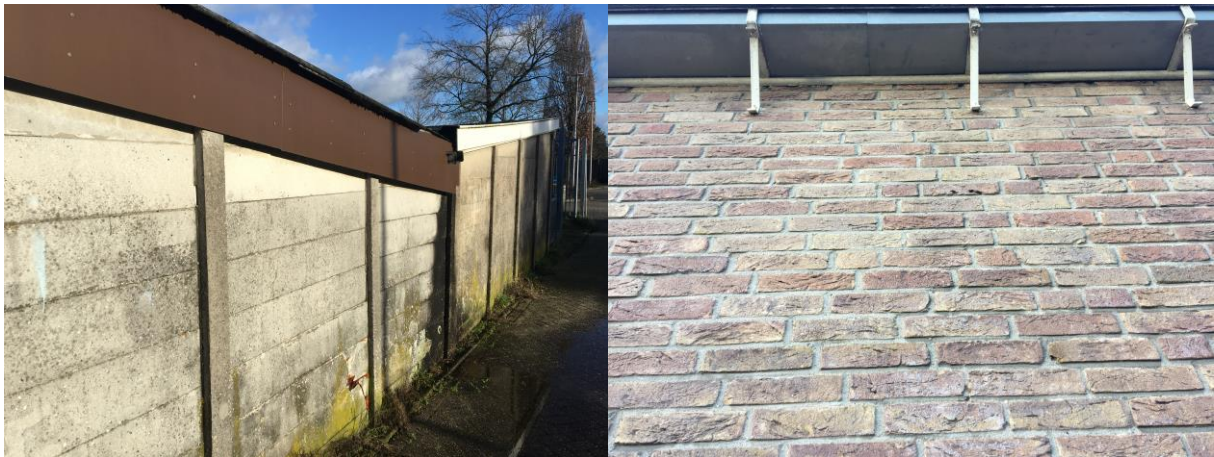
Detailopnames van de buitengevel van de garagebox (links) en het te slopen deel van het horecapand (rechts). De gebouwen worden niet als een potentiële verblijfplaats voor vleermuizen beschouwd.
