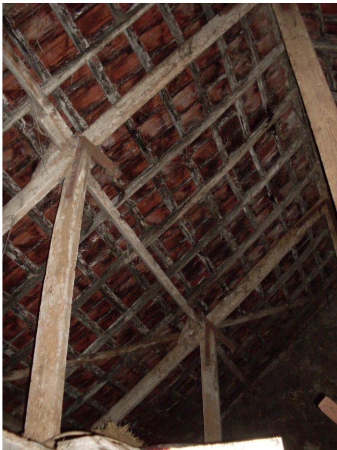
Onbeschoten dakconstructie halfsteens/steens stal
