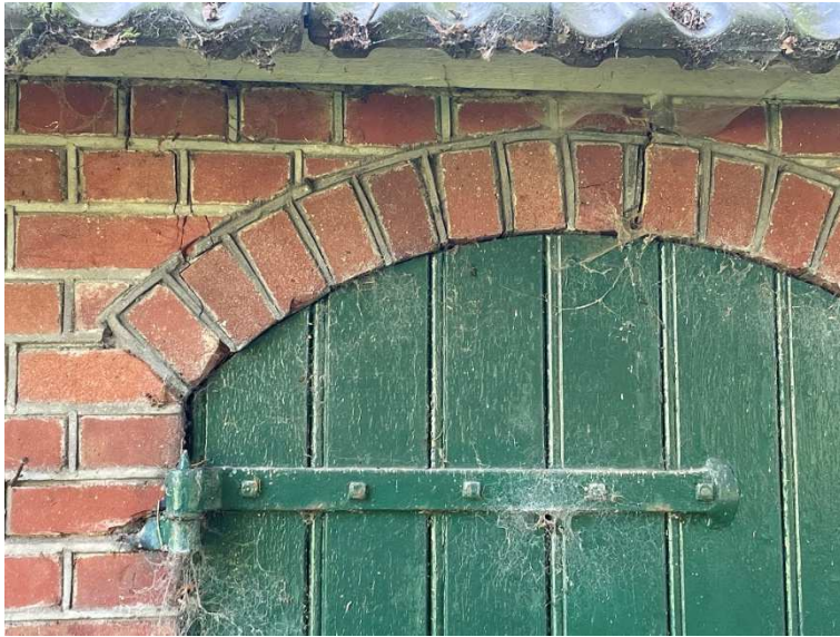
Foto: fragment scheur boven deur
