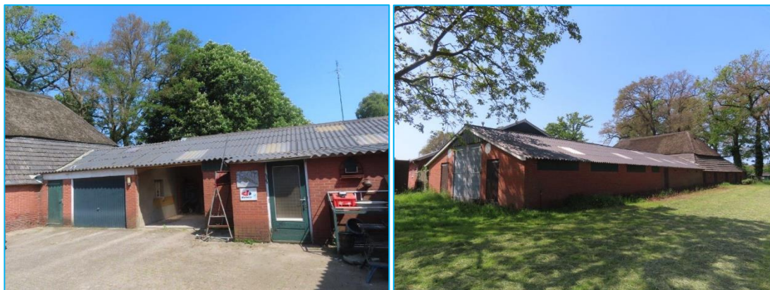
Foto's: Indrukken plangebied. De (deels) te amoveren aanbouw.
