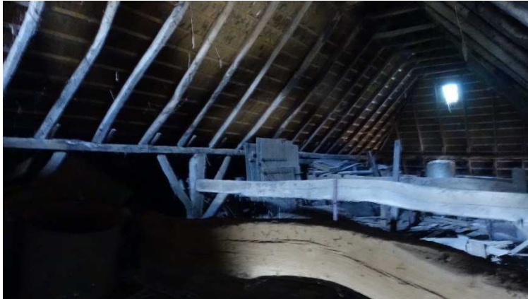
Foto: overzicht verdieping
