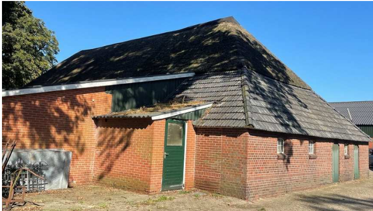
Foto: linkerzijgevel, achtergevel
