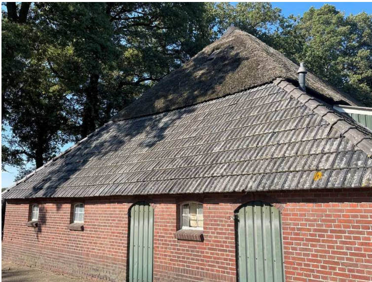
Foto: overzicht dak, deels met riet en deels met pannen gedekt
