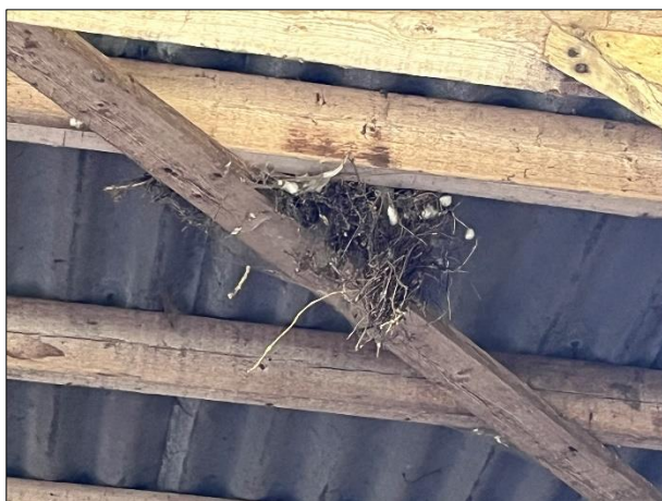
Duivennest in de kapschuur.
