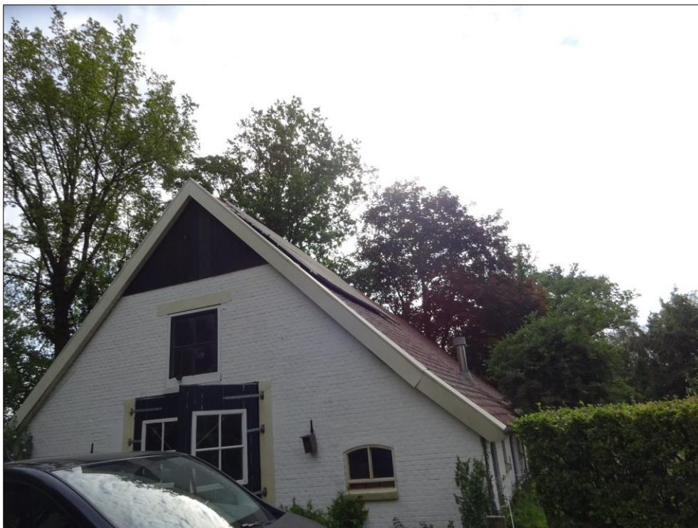
Figuur 1.4 Te renoveren schöppe gezien vanaf zuidwestzijde.
