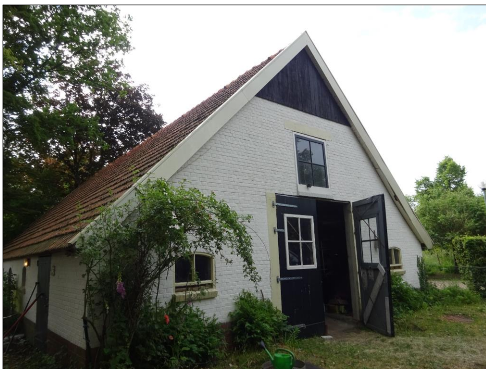
Figuur 1.2 Te renoveren schöppe gezien vanaf noordwestzijde.
