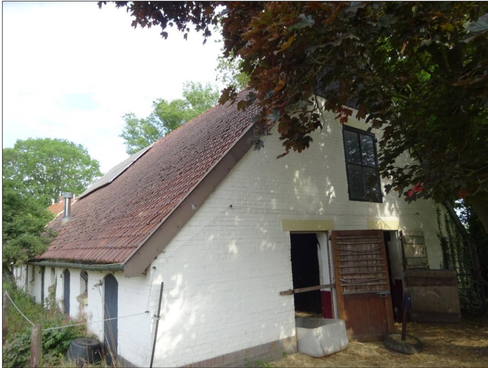
Figuur 1.3 Te renoveren schöppe gezien vanaf zuidoostzijde.
