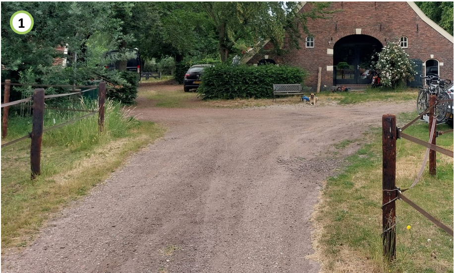
Aansluiten bij de bestaande halfverharding 'Mijnsteen'
