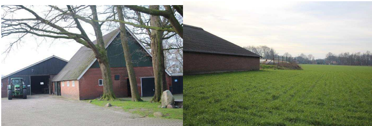
Figuur 3. Foto met de te slopen stal (rechter gebouw) en de nieuwbouwlocatie.
