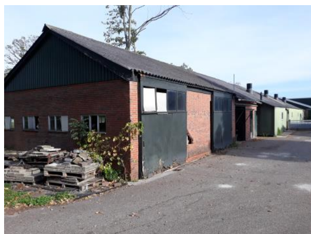
1 e deur schuur C. 2 e deur schuur D. (worden gesloopt)
