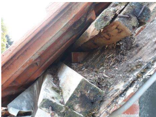
Ruimte onder dakpannen deellocatie A (blijft behouden).
