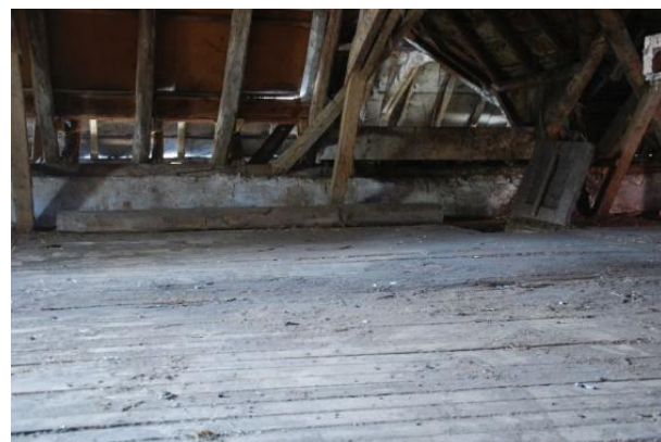
De scheidingsmuur tussen de vleugels 1 en 2 op zolderniveau. In de muur zijn zware eiken staanders opgenomen die met een pen-en-gat verbinding in de muurplaat steken. Op lager niveau is van deze stijlen niets te zien. Mogelijk zijn het de stijlen van ankerbalkgebinten uit de houtbouwphase, die met de versterking van vleugel 1 grotendeels werden verwijderd.
