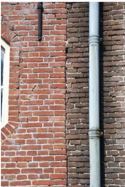
De oostgevel van het bouwhuis, met boven een overzicht en daaronder de gevels van de vleugels 2 en 1. De naad tussen beide laat duidelijk zien dat het muurwerk van vleugel 1(rechts) is afgehakt en dat van vleugel 2 er koud tegen aan staat.
