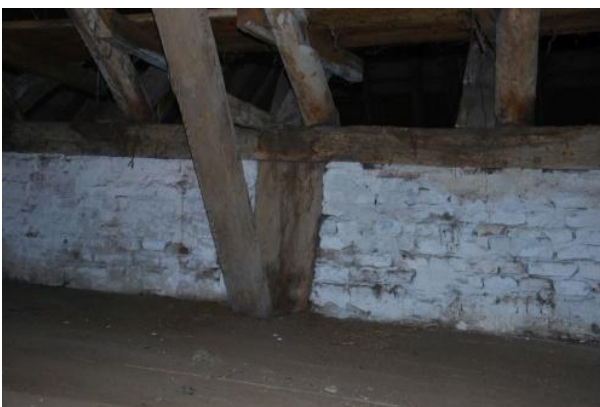
De scheidingsmuur tussen de vleugels 1 en 2 op zolderniveau. In de muur zijn zware eiken staanders opgenomen die met een pen-en-gat verbinding in de muurplaat steken. Op lager niveau is van deze stijlen niets te zien. Mogelijk zijn het de stijlen van ankerbalkgebinten uit de houtbouwphase, die met de versterking van vleugel 1 grotendeels werden verwijderd.
