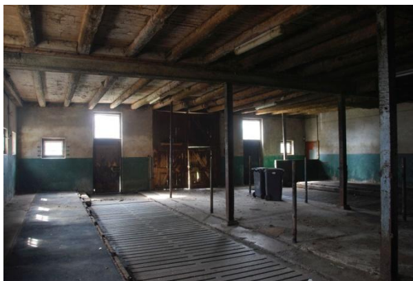
De veestalling in vleugels 2 en 3 naar het zuiden gezien met in het midden de deel, geflankeerd door ligboxenstallen met betonnen stalroosters..
