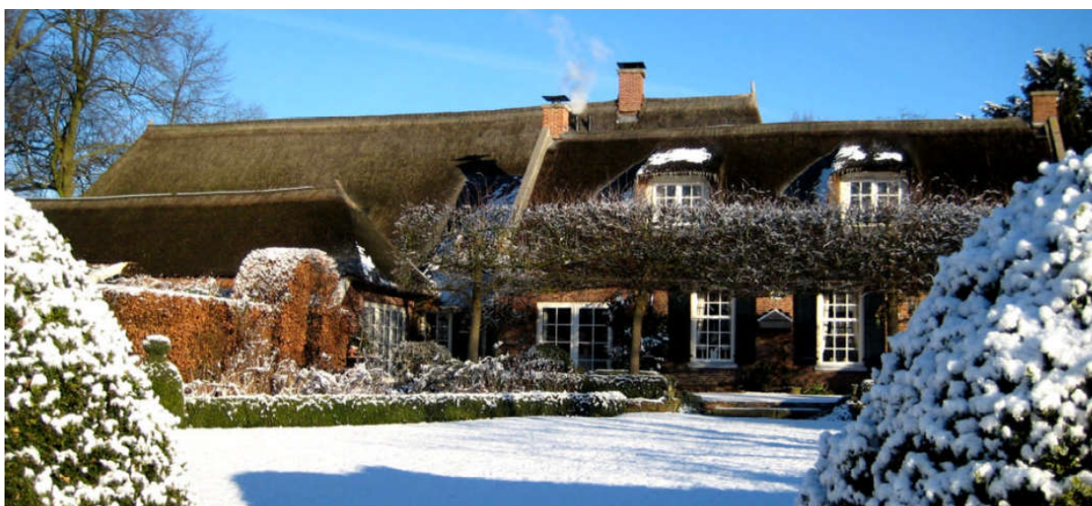
Daarna werd in 2002 het gehele dak van het hoofdgebouw, alsmede alle voegwerk met BRM-subsidie gerestaureerd.
