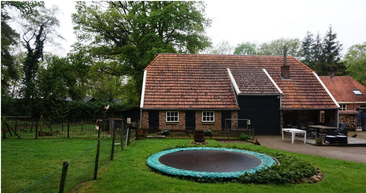
Figuur 2.4. Zijaanzicht van de schuur.
