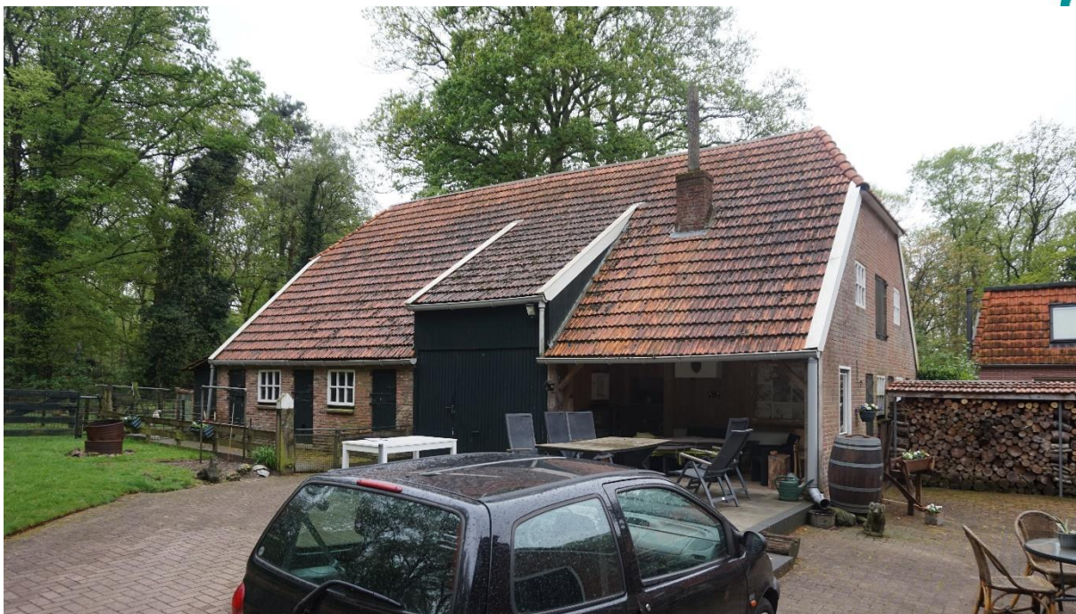
Figuur 2.2. Zijaanzicht van de schuur.
