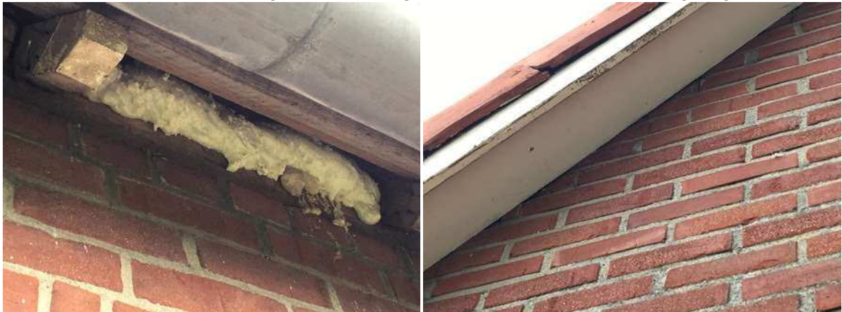
Foto links: openingen in de woonboerderij zijn afgedicht met purschuim. Foto rechts: de betimmering van de overstek is strak tegen de buitengevel bevestigd. Hierdoor kunnen vleermuizen niet de spouw betreden.
