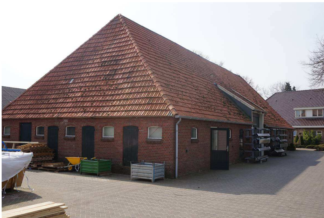
Figuur 2.2. De achterzijde en westzijde van de te slopen schuur.
