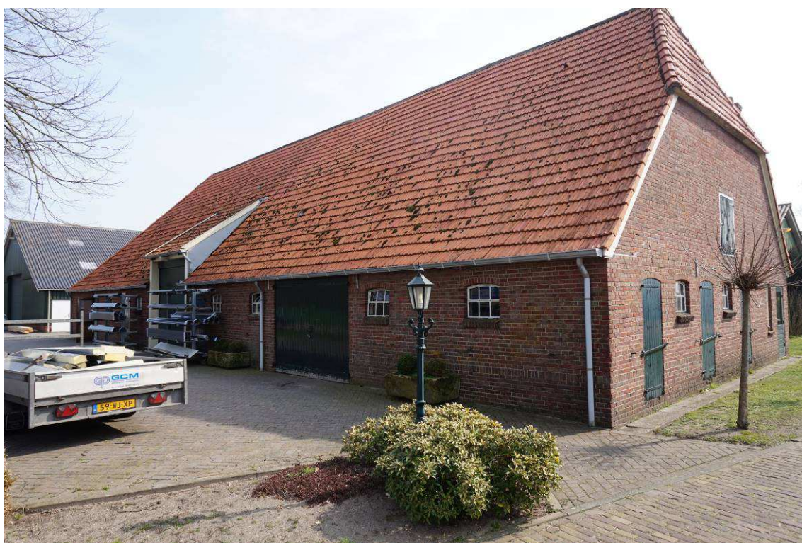
Figuur 2.5. De voorzijde en oostzijde van de te slopen schuur.
