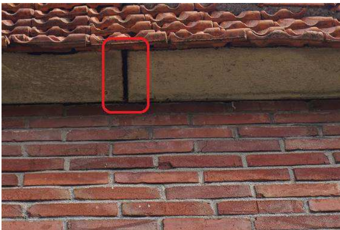
Figuur 5.4 Uitsparing in de boeiborden.
