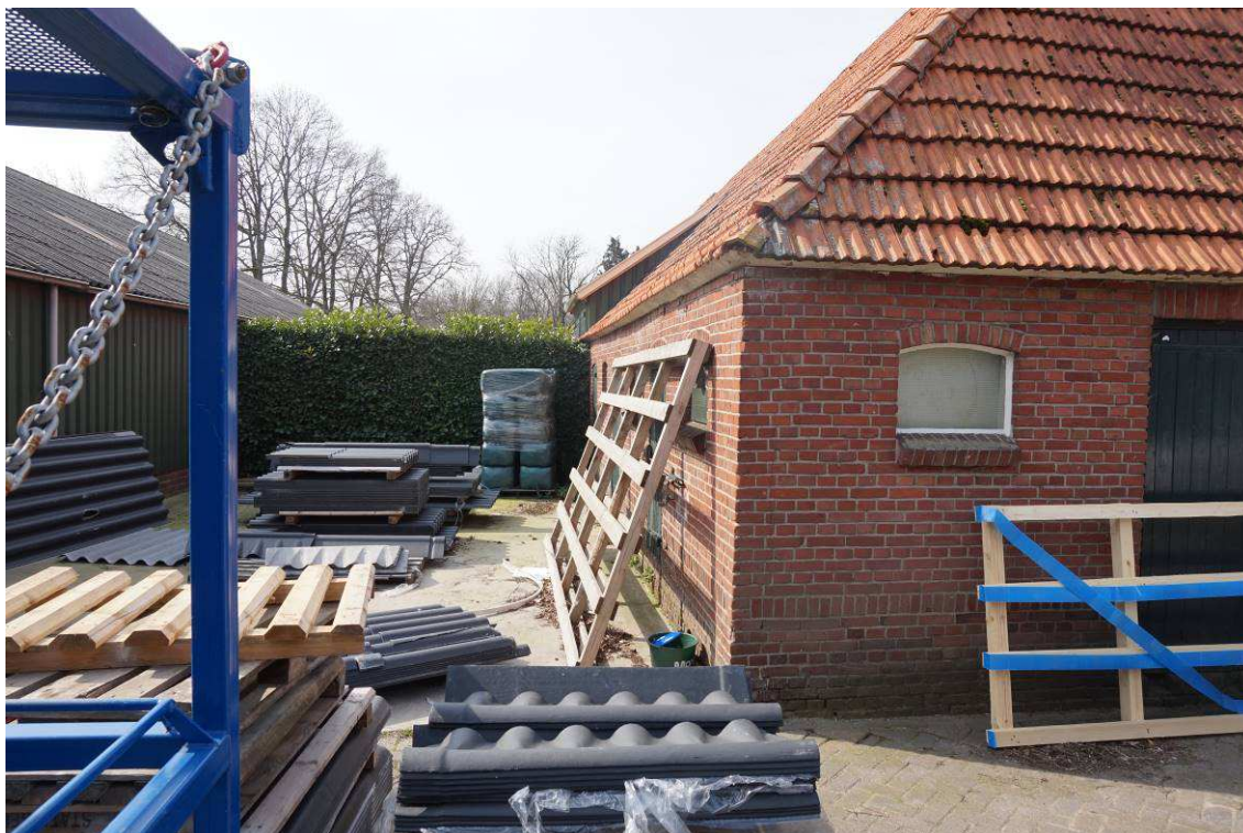
Figuur 2.3. De achterzijde en oostzijde van de te slopen schuur.
