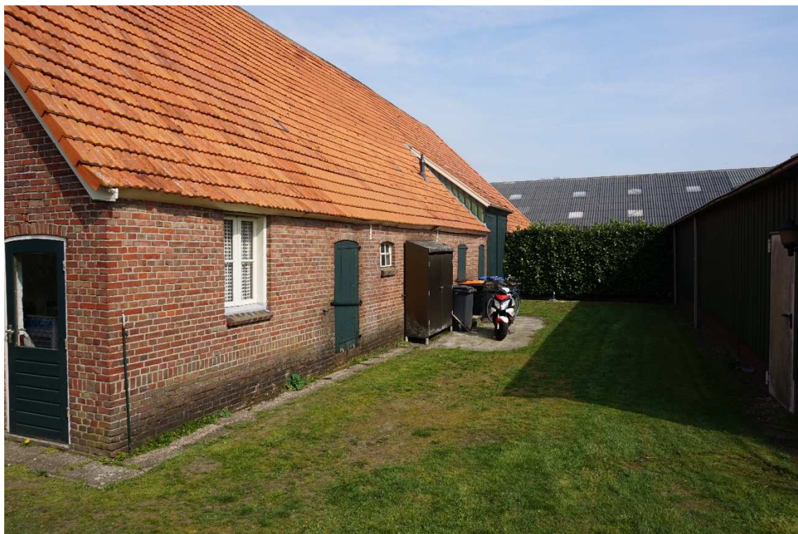
Figuur 2.4. De voorzijde en oostzijde van de te slopen schuur.
