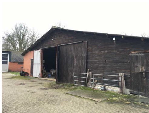
Figuur 6. Koeienstal van gebouw 3.
