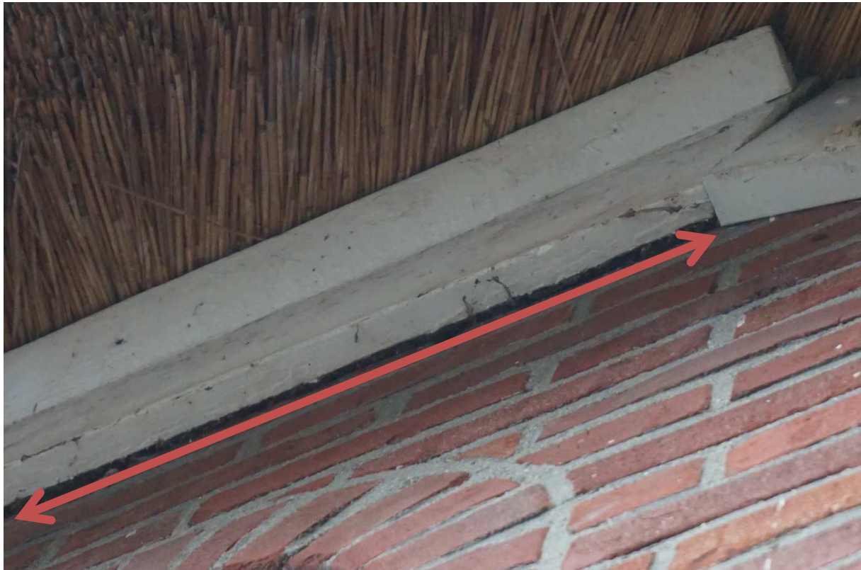
Figuur 5.2. Potentiële verblijfplaats vleermuizen tussen gevel en houtwerk.
