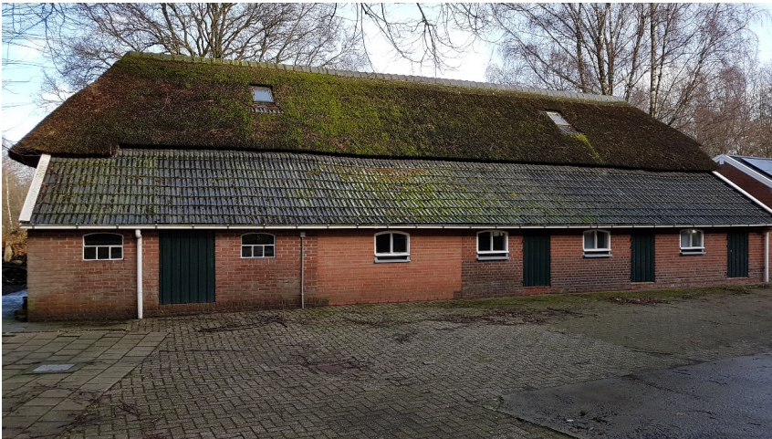
Foto schoppe, zuidzijde: De locatie van de voormalige dwarsdoorgang is duidelijk zichtbaar
