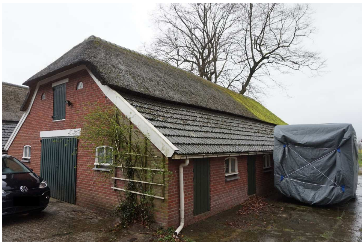
Figuur 2.5. Voorzijde en oostzijde van de te verbouwen schuur.
