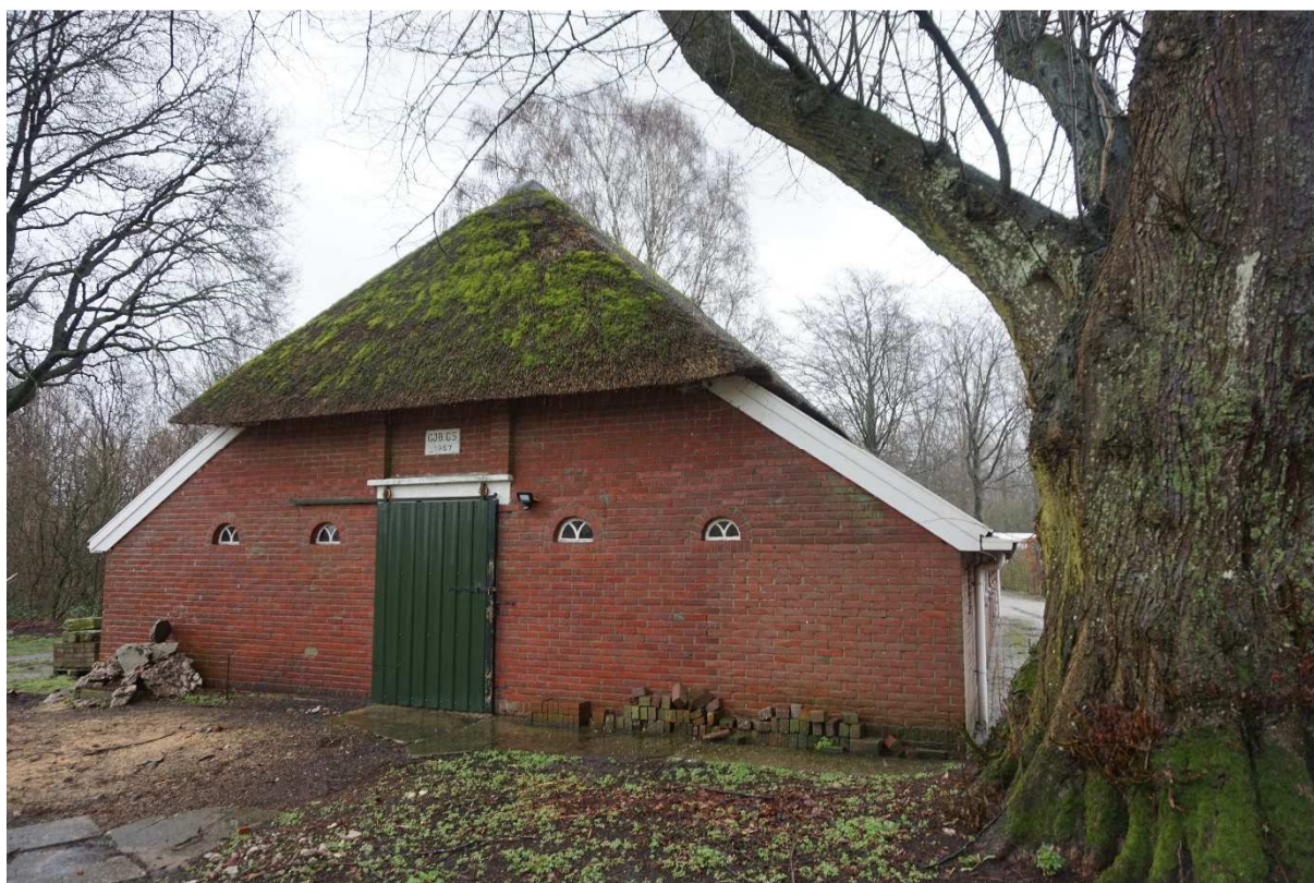
Figuur 2.3. Achterzijde van de te verbouwen schuur.
