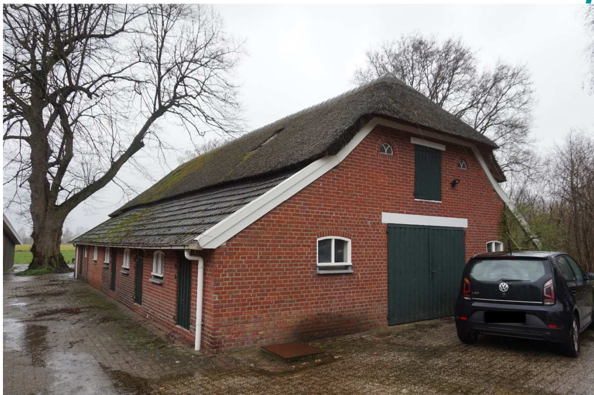
Figuur 2.2. Voorzijde en westzijde van de te verbouwen schuur.
