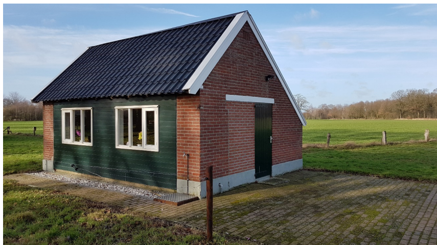
Voormalige kippenschuur (Gebouw F)
