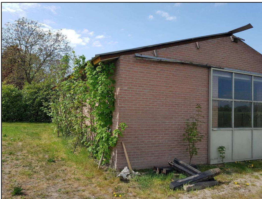
Figuur 4. Schuur met voorheen een agrarische functie, nu in gebruik voor opslag van diverse spullen.
