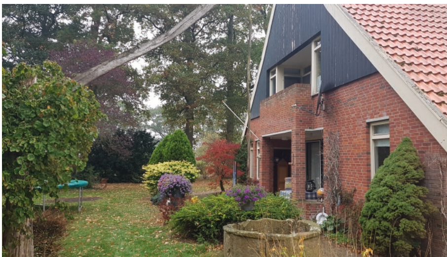
Foto C: De kopgevel (voorgevel) van de karakteristieke Twentse boerderij. Tevens is de waterput met haal te zien.
