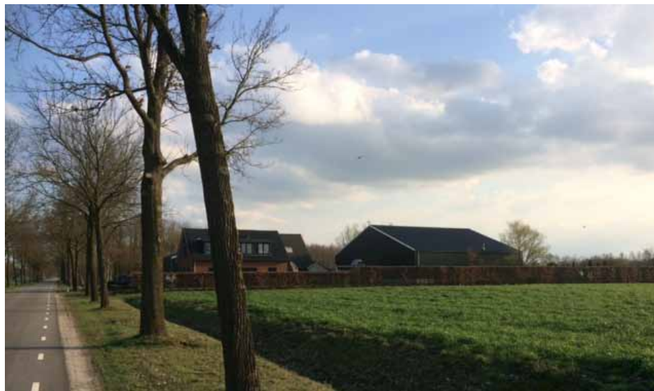
Afbeelding 5. Het bebouwde deel van het erf ligt hoger dan de parallelweg van de N755
