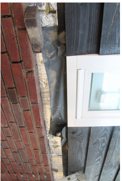
Afbeelding 23. Referentie toepassing van hout in zwart met potdeksel en rode baksteen
