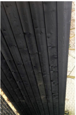
Afbeelding 23. Referentie toepassing van hout in zwart met potdeksel en rode baksteen
