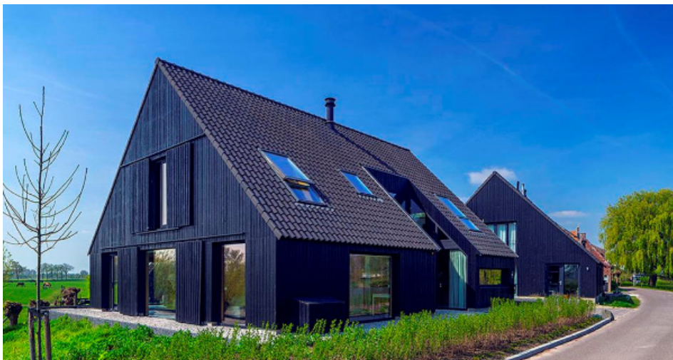
Afbeelding 17. Schuurwoningen in Nederhorst ten Berg, cross laminated timber-woningen door Schipper-Douwes
