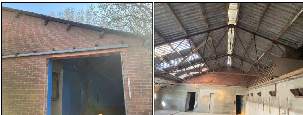
Figuur 2.8 (links): Ingang van de voormalige rundveestal; Figuur 2.9 (rechts): De voormalige rundveestal maakt een opgeruimde indruk. Er is geen dakisolatie aanwezig.
