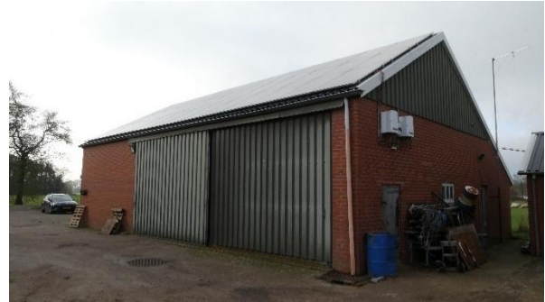
Figuur 11: Te behouden garage/loods
