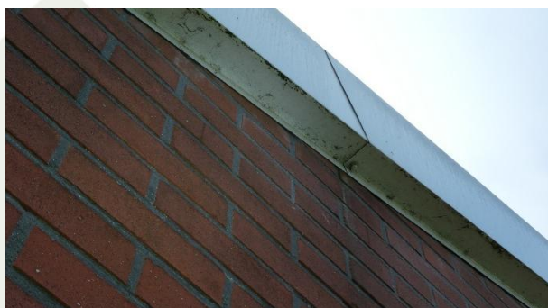
Figuur 20: Bovenzijde gevels volledig afgesloten.
