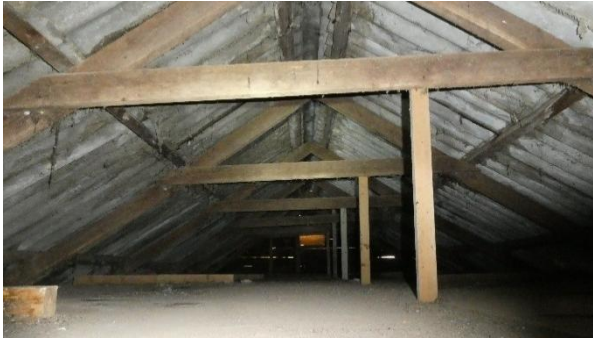
Figuur 4: Zolderruimte te amoveren schuur geïnspecteerd
