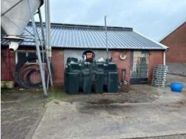
Figuur 9: Bovengrondse dieseltank
